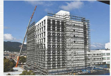
旧本館解体の様子
