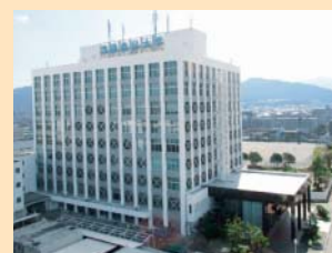
完成した本館
