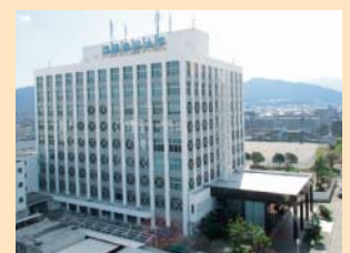
完成した本館
