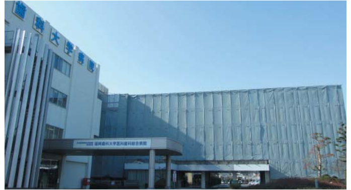
防音シートに覆われた研究棟
