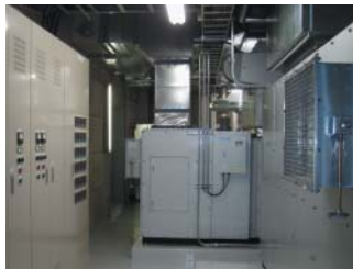
工事が完了した空調機械室
