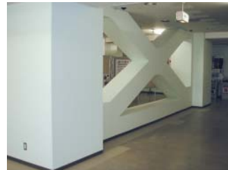
本館1階ロビーの耐震ブレース
