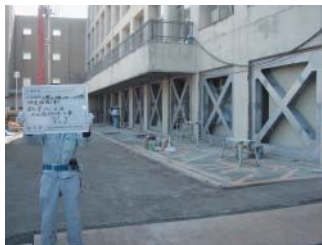
本館1階に設置された鉄骨ブレース
